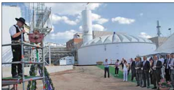
Die Feierlichkeiten zum Richtfest des neuen Ersatzbrennstoff-Heizkraftwerkes wurden von vielen Besuchern aufmerksam verfolgt.
