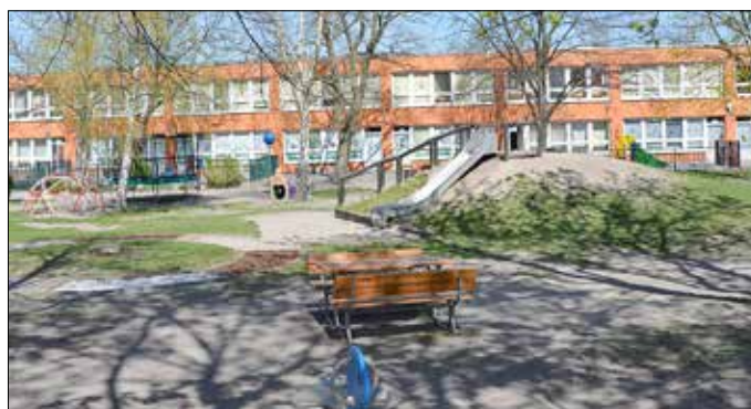
Im Kita-Gebäude finden sich ab dem 01.01.2020 die Kitas „Fuhnetal I“ und „Fuhnetal II“. Foto: Stadt Bitterfeld-Wolfen
