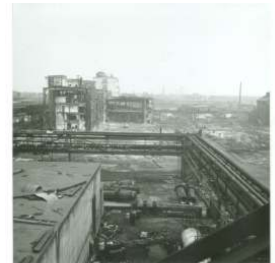
September 1968: Der PC-Betrieb im Werk Süd des Elektrochemischen Kombines Bitterfeld (EKB) nach der Explosion vom 11. Juli 1968. Dahinter: Neubau Bi 58.
